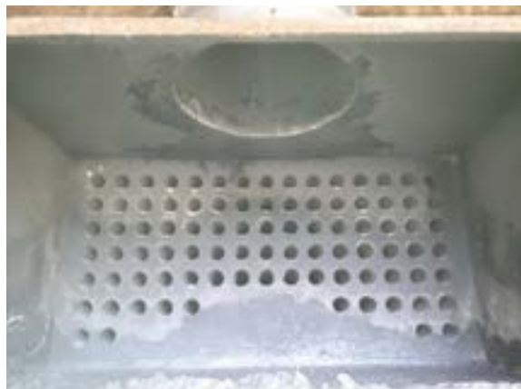
L'échangeur tubulaire
